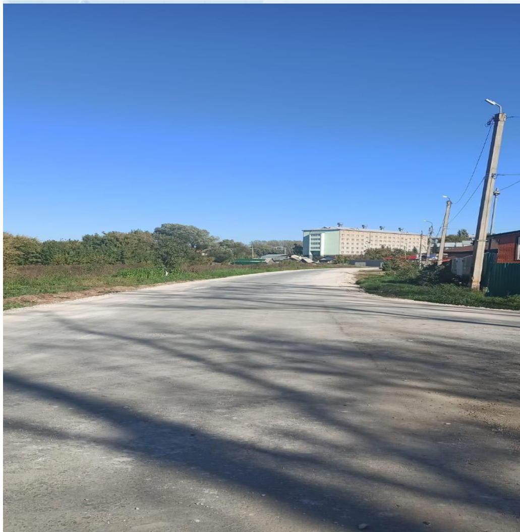
Ремонт дороги по ул. 1-й проезд Фрунзе
